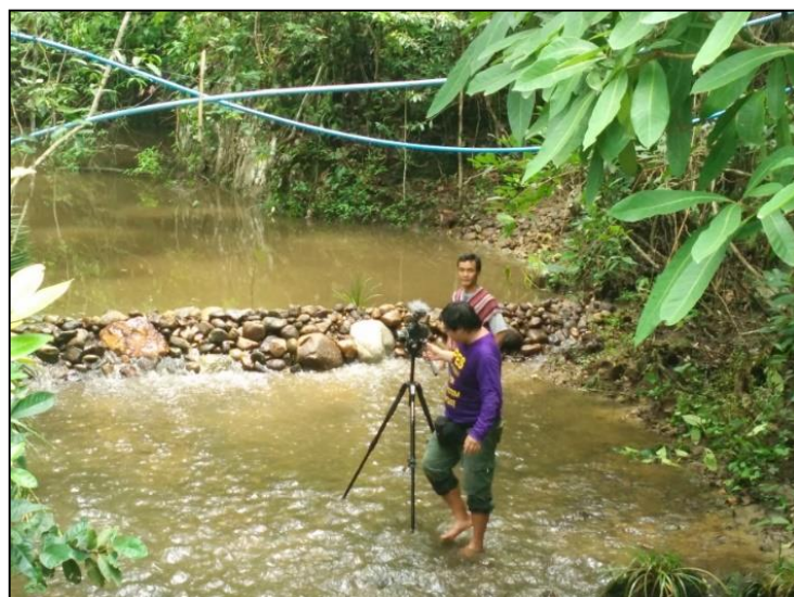
ภาพที่ 4.2 ภาพฝายชะลอน้ำที่สร้างสำเร็จแล้ว
