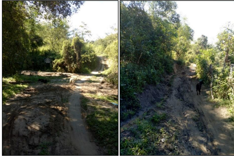
ภาพที่ 4.6 ถนนที่ชาวบ้านใช้สัญจรได้รับความเสียหายจากอุทกภัย
